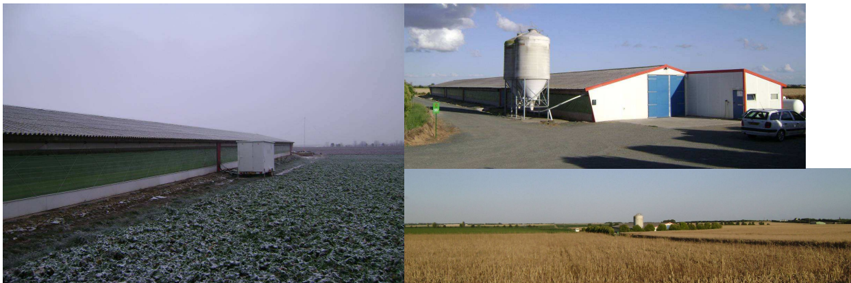
Figure 1. Aperçu général du bâtiment
